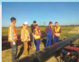
MONTER SIECI I INSTALACJI SANITARNYCH
